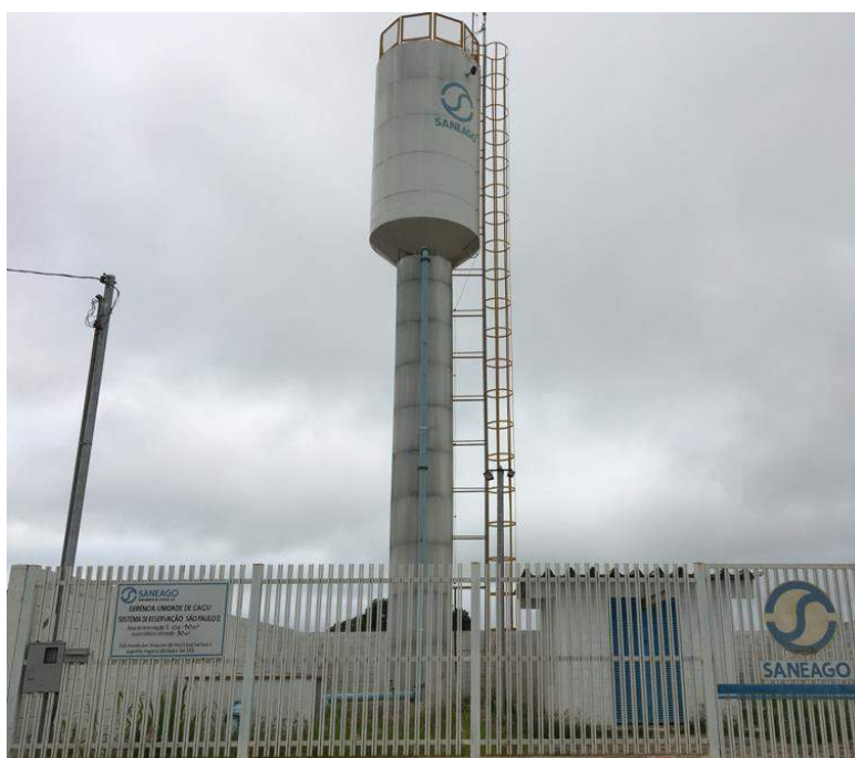
Reservatório R9 – Fonte: Visita Técnica
