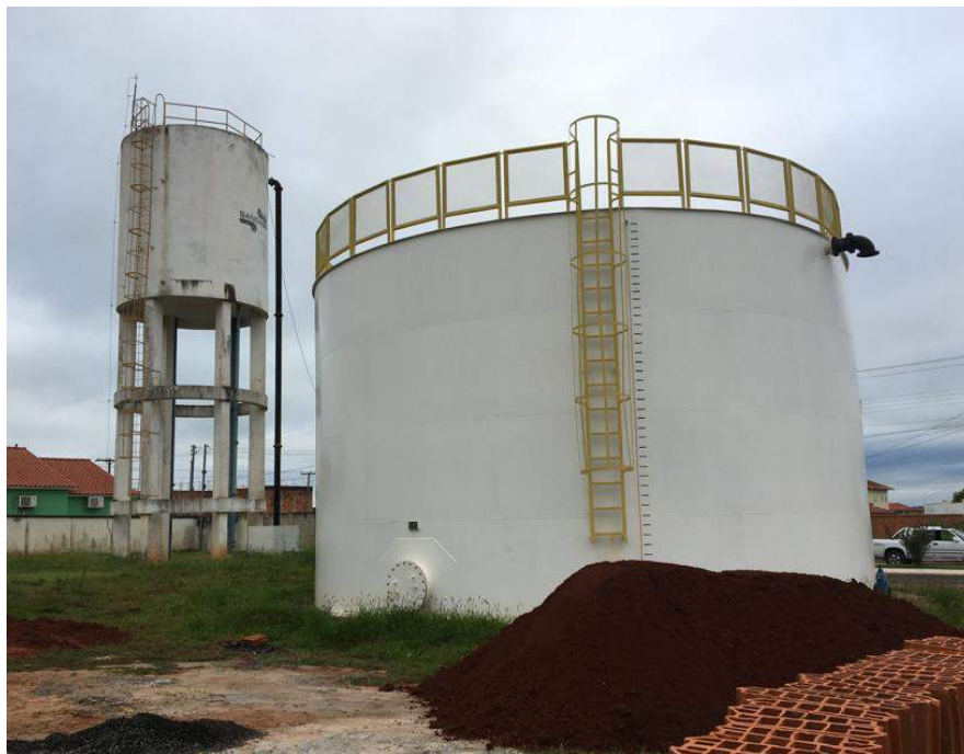
Reservatórios R3 e R8 – Fonte: Visita Técnica
