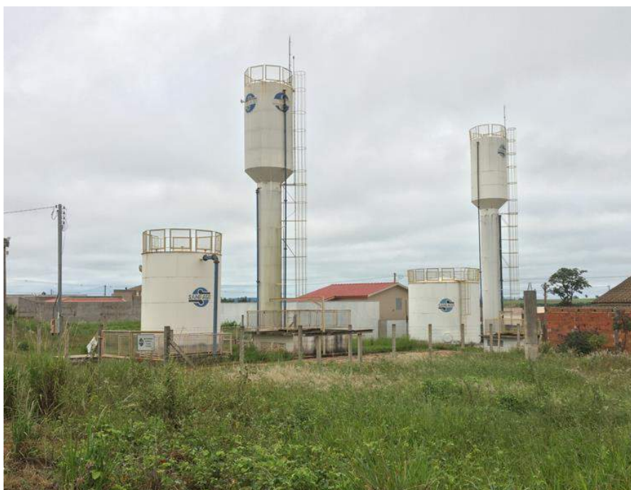
Reservatórios R4, R5, R6 e R7 – Fonte: Visita Técnica
