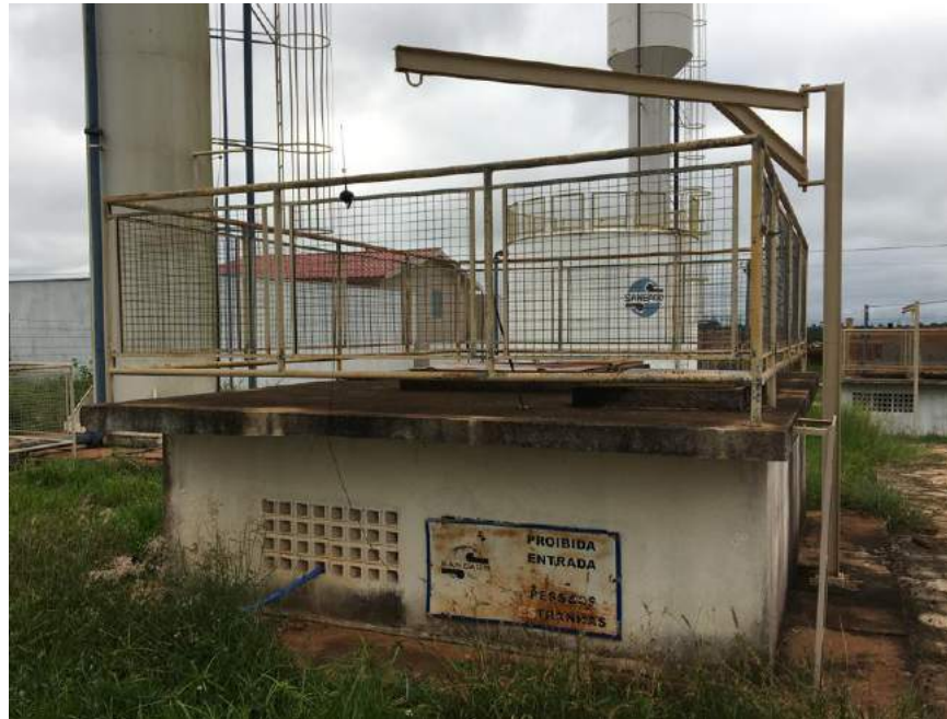
EEAT 2 - Fonte: Visita Técnica
