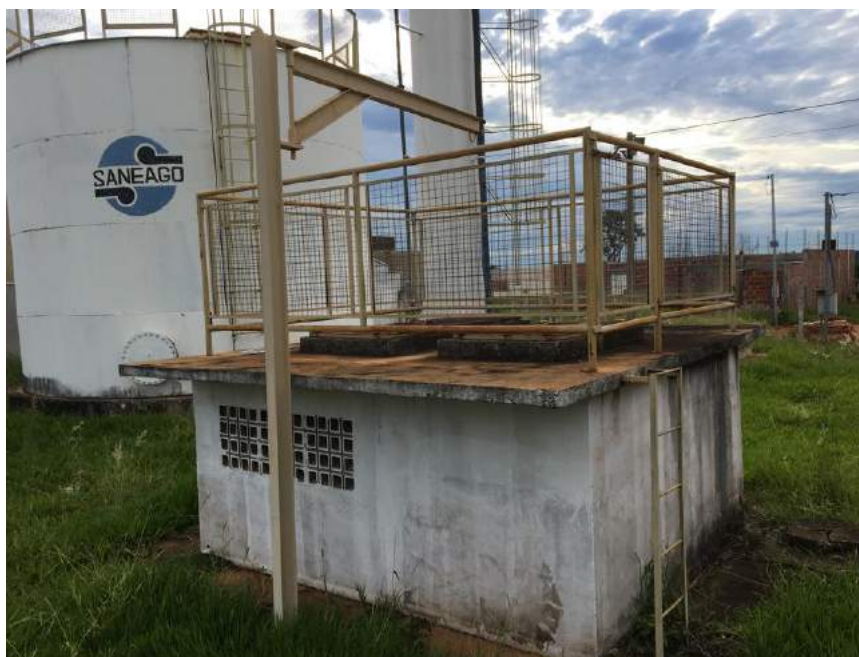
EEAT 3 - Fonte: Visita Técnica
