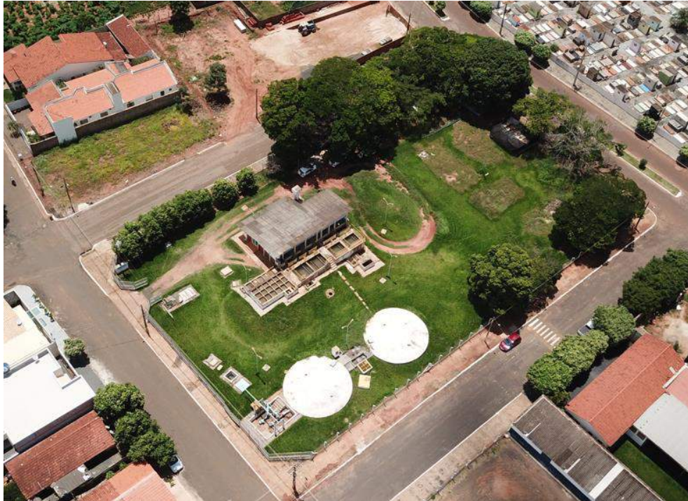
Reservatórios R1 e R2 – Fonte: Visita Técnica
