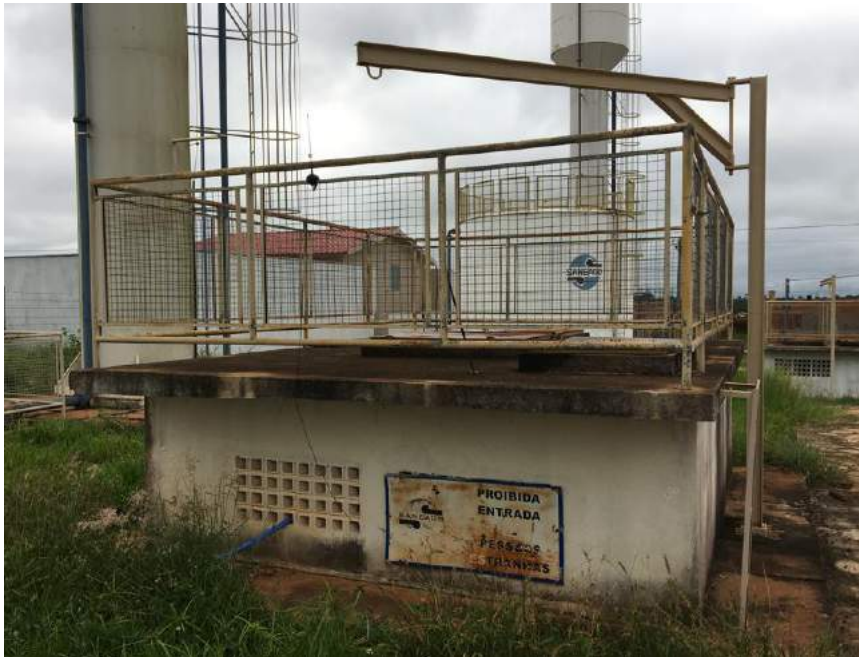
EEAT 2 - Fonte: Visita Técnica
