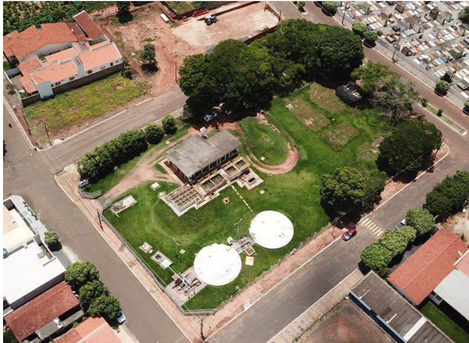
Reservatórios R1 e R2 – Fonte: Visita Técnica
