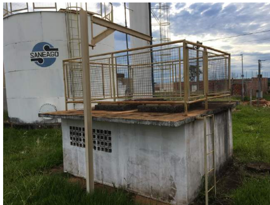
EEAT 3 - Fonte: Visita Técnica
