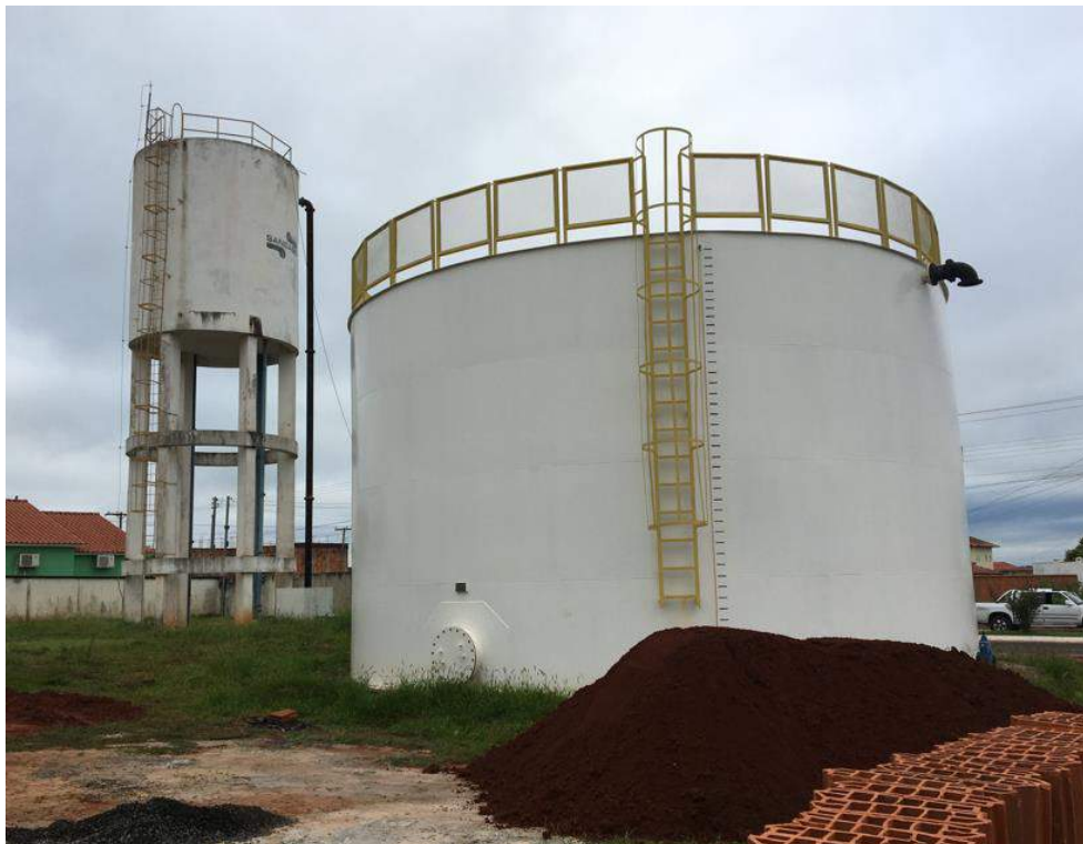
Reservatórios R3 e R8 – Fonte: Visita Técnica
