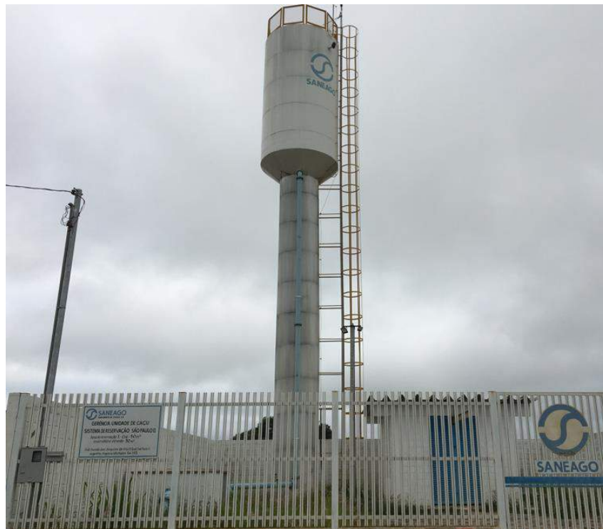
Reservatório R9 – Fonte: Visita Técnica
